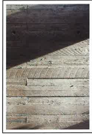
BÉTON APPARENT, COFFRAGE AVEC PLANCHES DE BOIS
